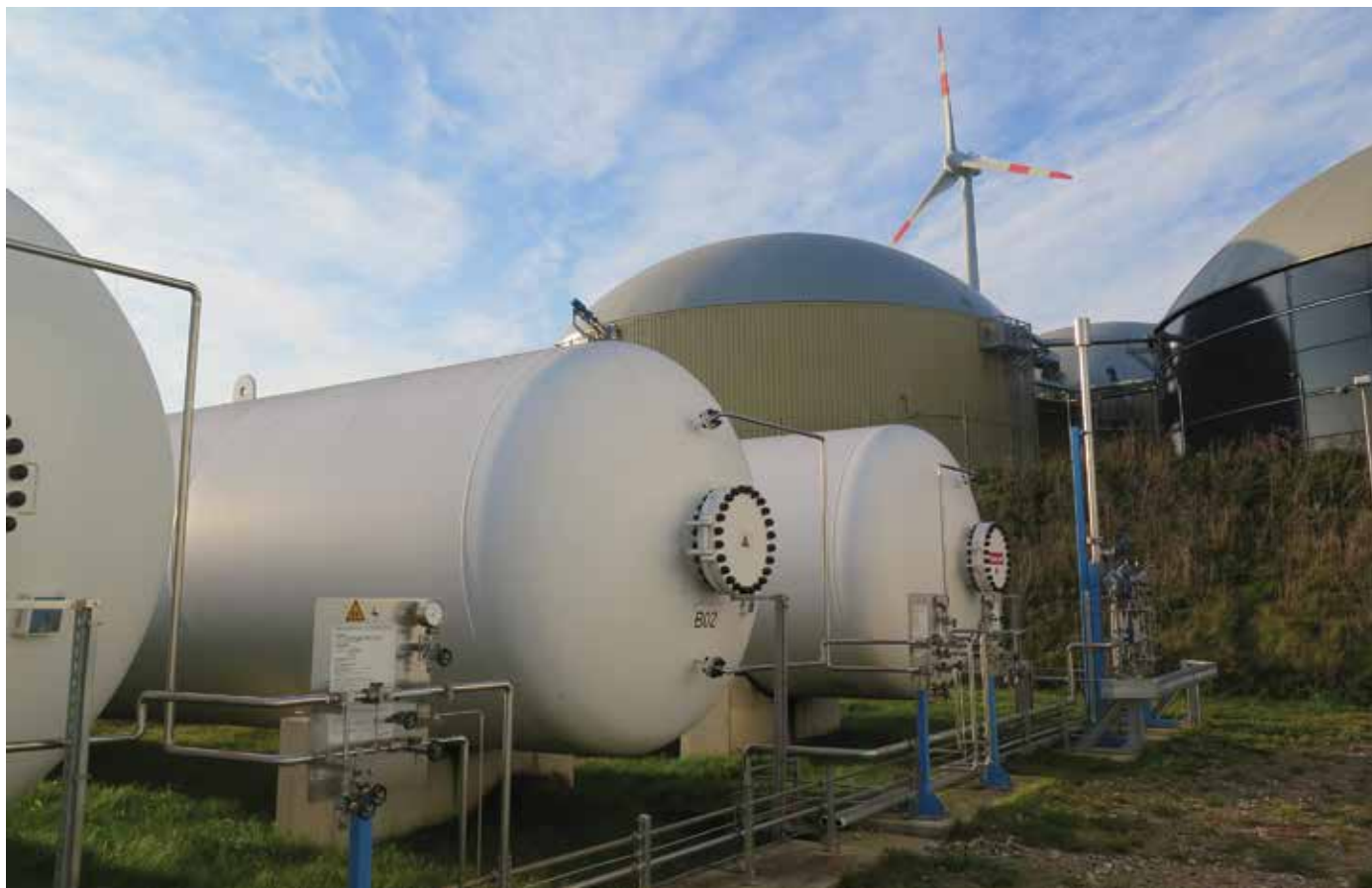
Резервуары для хранения водорода
