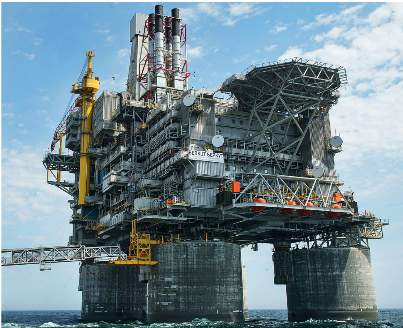
Крупнейшая в России морская нефтегазовая буровая платформа «Беркут» работает на месторождении Аркутун-Даги проекта «Сахалин-1» с июня 2014 года. Установлена в 25 км от берега на участке Охотского моря глубиной 34 м. Способна бурить и обслуживать до 45 скважин в круглогодичном режиме при температуре воздуха до -44^{\circ}\text{C} и давлении ледовых полей толщиной до двух метров. Верхняя часть платформы изготовлена в Южной Корее. Основание платформы построено в Находке
